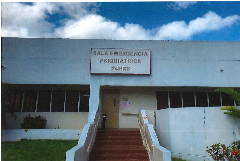
Foto #2 Sala de Emergencia
