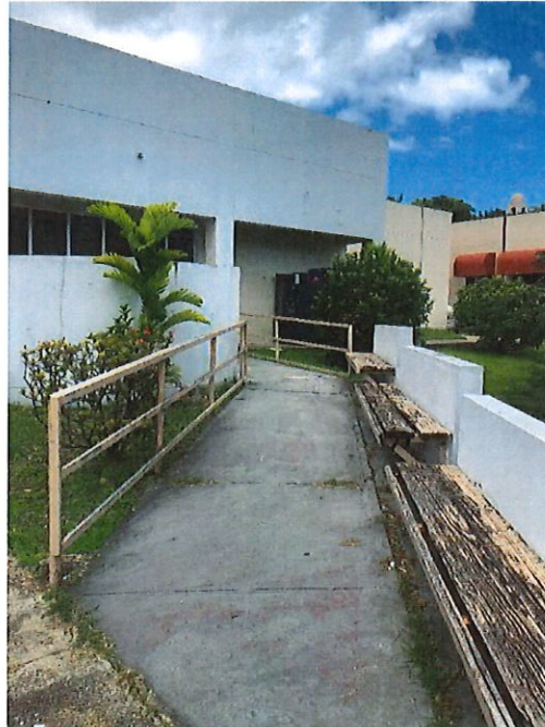
A-5 Bancos en concreto
