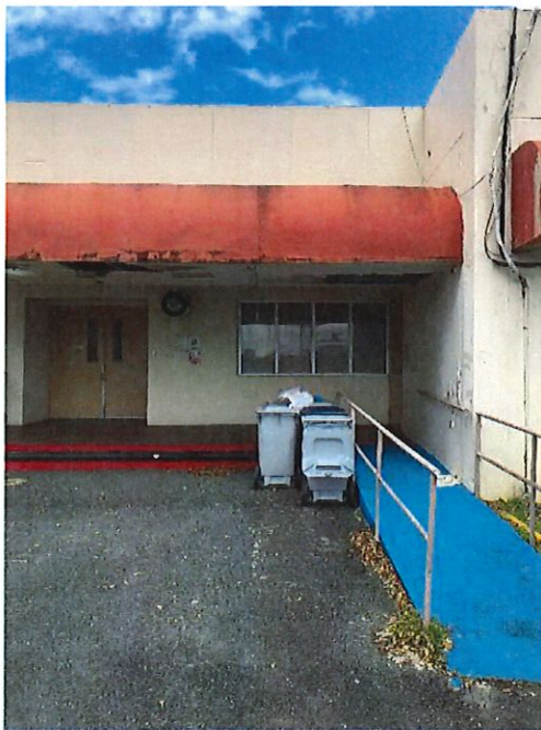
A-6 Techo Área de Ambulancias
