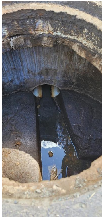
Foto 1: Manhole que se encuentra a 3ft de profundidad
