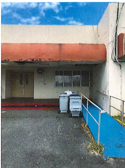
A-6 Techo Área de Ambulancias
