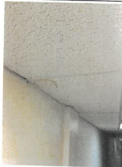
Photo 22 – Hallway, Oficina Central de Asuntos de SIDA y Enfermedades Transmisibles (OCASET), damaged acoustic tiles (2 FT wide by 4 FT height)
