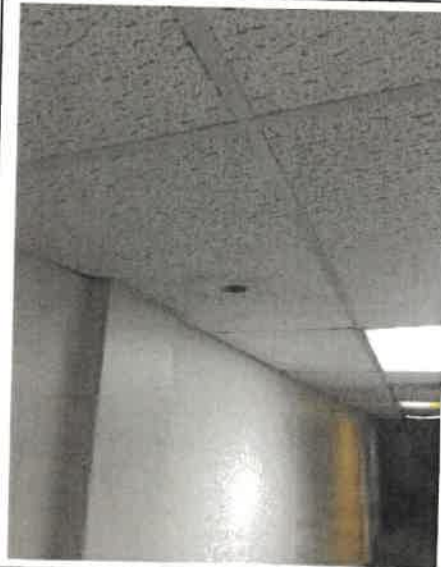
Photo 22 – Hallway, Oficina Central de Asuntos de SIDA y Enfermedades Transmisibles (OCASET), damaged acoustic tiles (2 FT wide by 4 FT height)
