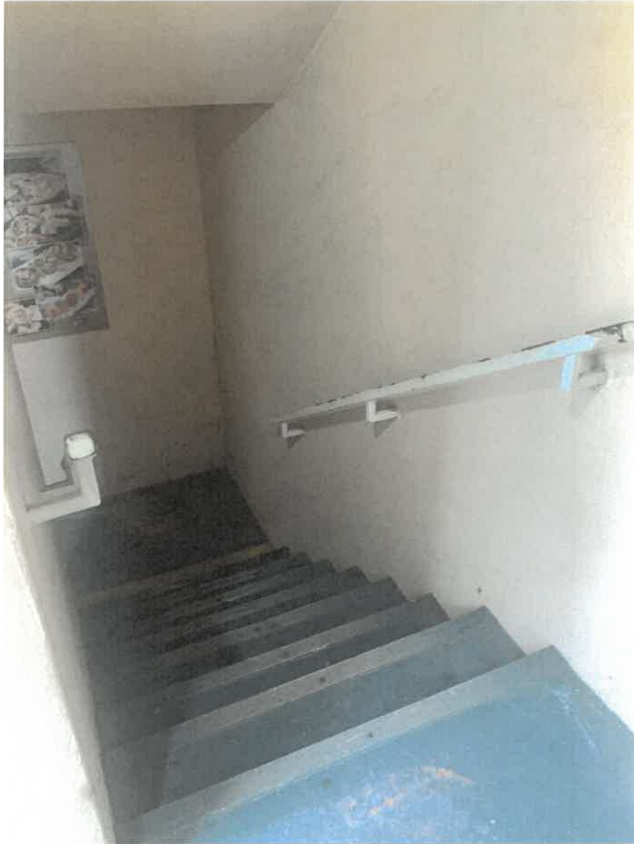
Barandales y Piso de las 2 escaleras exteriores.
