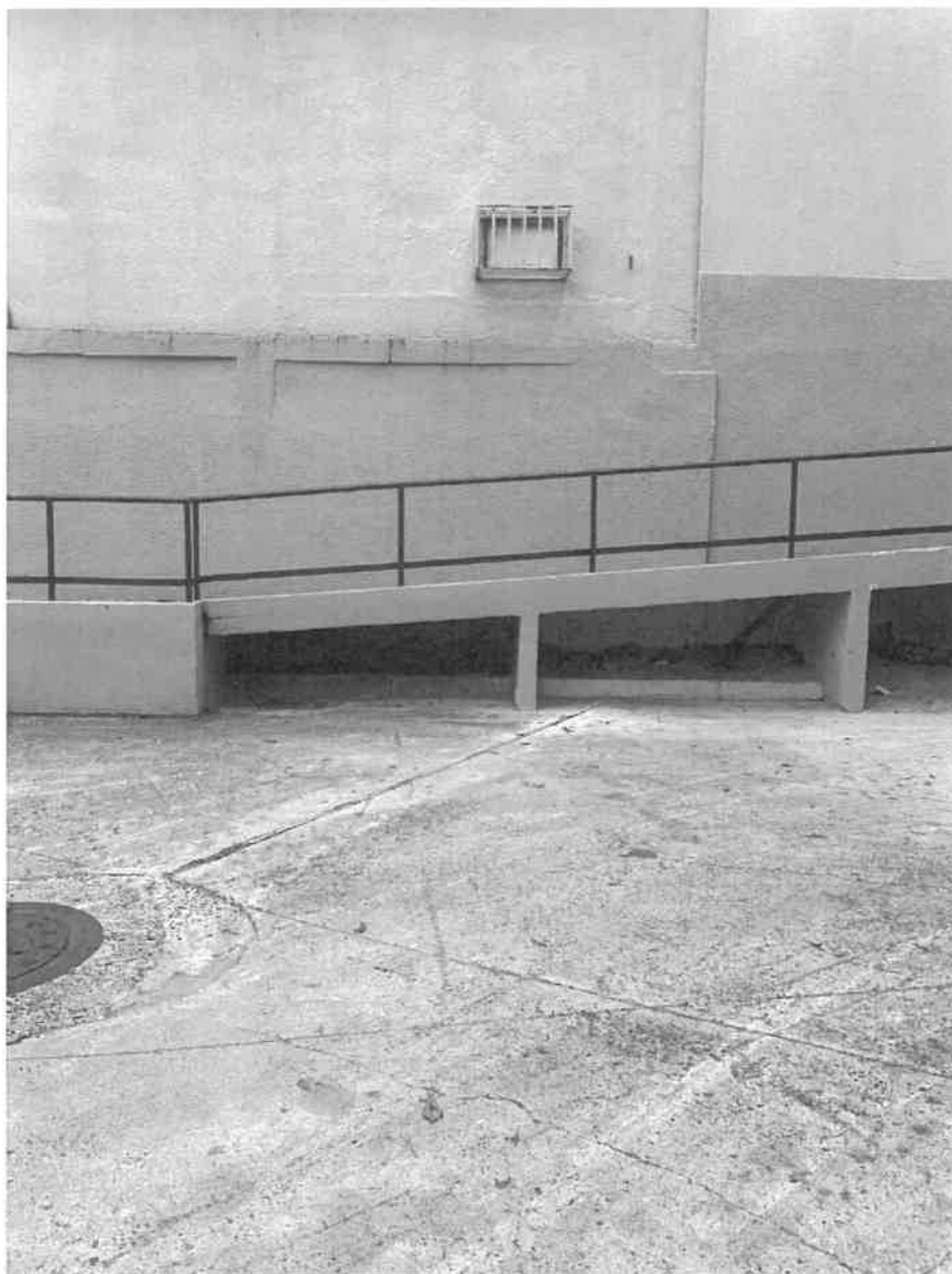
Barandal de Rampa
